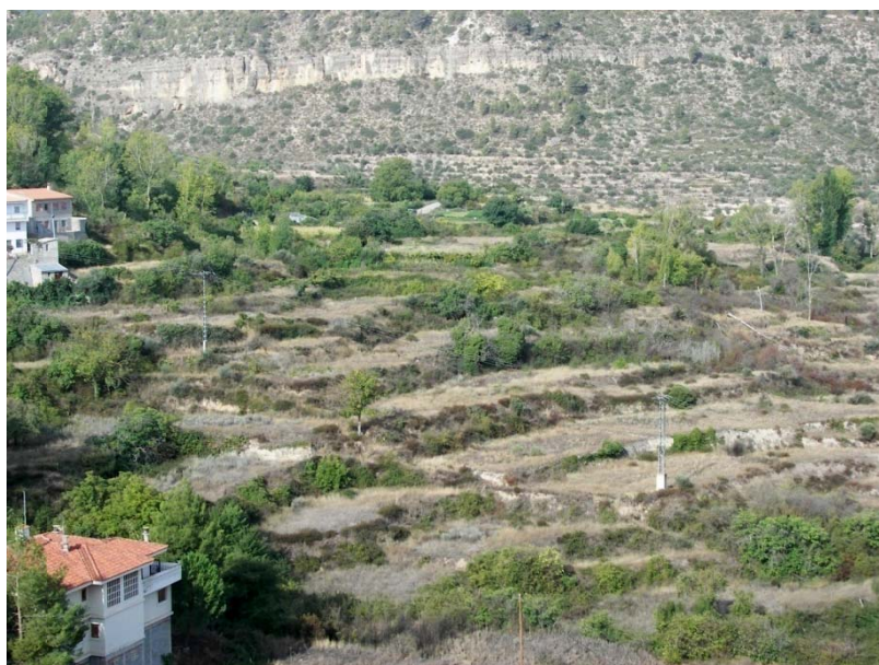
Bancales o aterrazamientos degradados. Enguídanos (Cuenca) Foto: Javier Herráiz y Lourdes López
